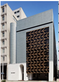
本社ビル改修
